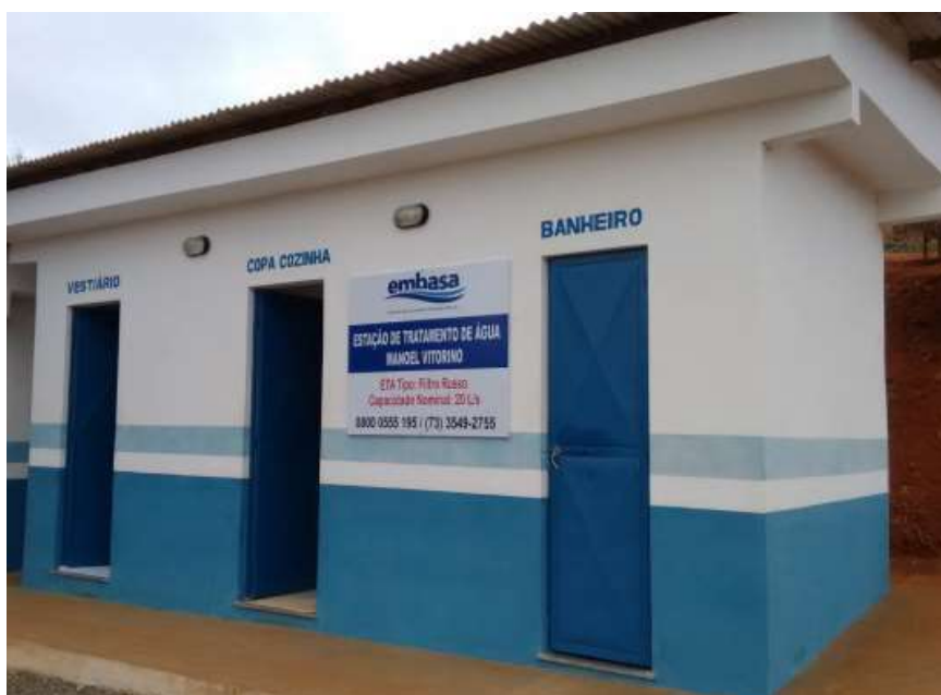
Foto 02 – Estação de Tratamento de Água
