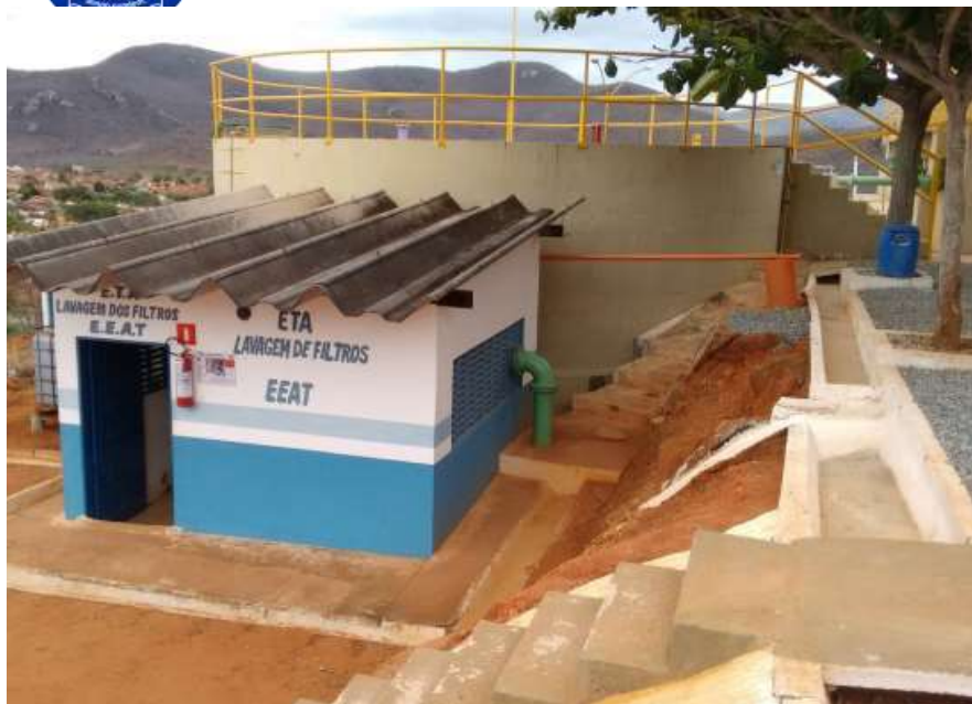
Foto 01 – Estação de Tratamento de Água
