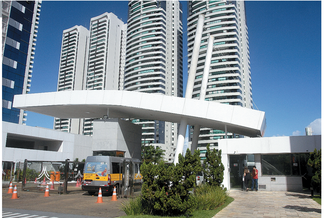
Caso aconteceu no domingo (9) em um apartamento de um condomínio na Avenida Paralela, em Salvador
