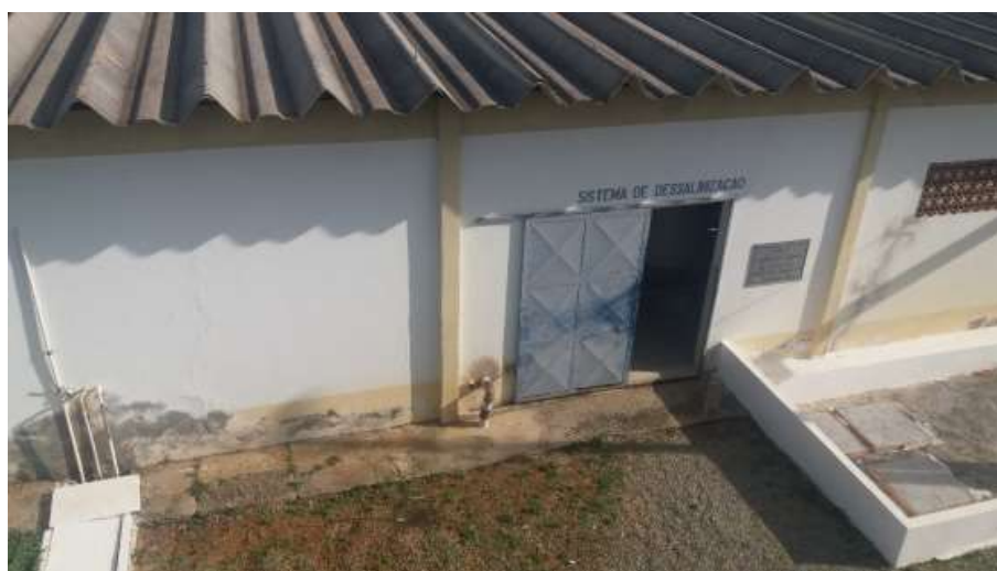
Figura 31 – Sistema de dessalinização do sistema da Embasa - Tremedal
