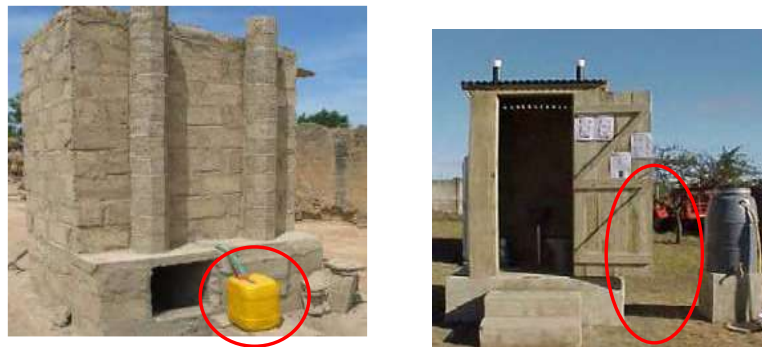
Figura 89 – Bombonas de armazenamento temporário (esquerda) e de estocagem (direita) em sanitário com separação de urina implantados em países da África.
