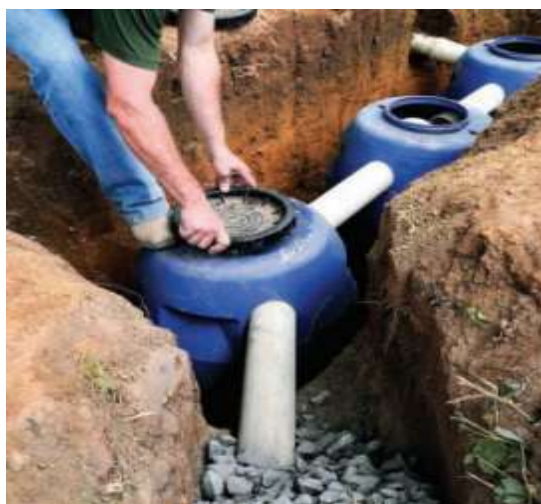
Figura 82 – Instalação das fossas sépticas econômicas
