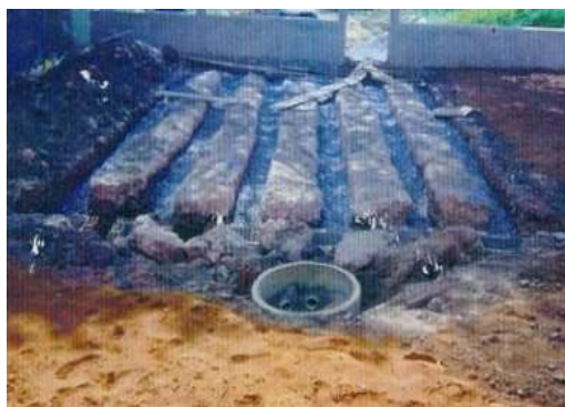
Figura 75 - Valas de infiltração construídas e esquema do leito filtrante
