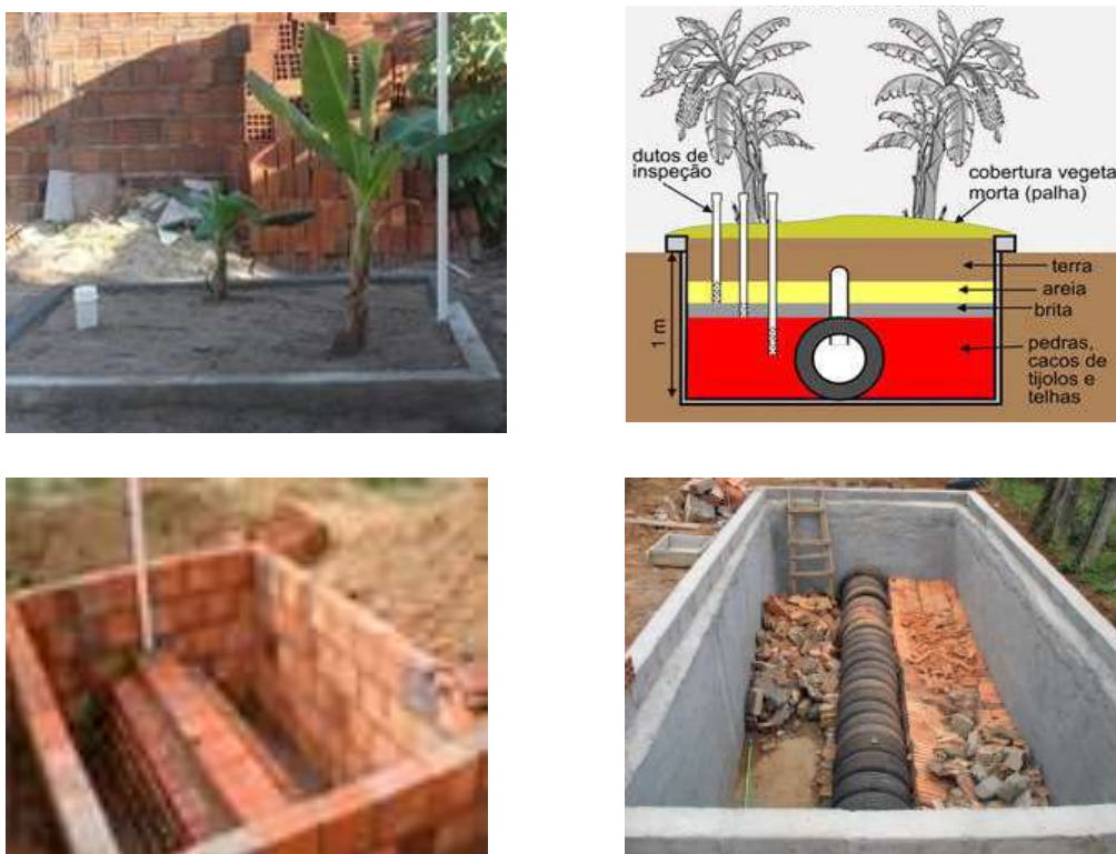
Figura 85 – Tanque de evapotranspiração
