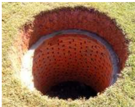
Figura 76 – Tipologia de sumidouro: sumidouro de tijolo
