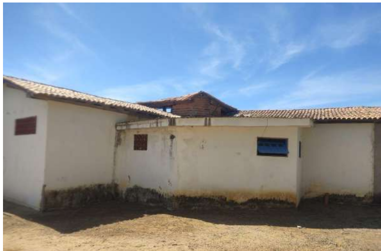
Figura 03 – foto da escola já existente
