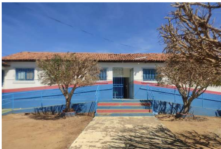
Figura 01 – foto da escola já existente
