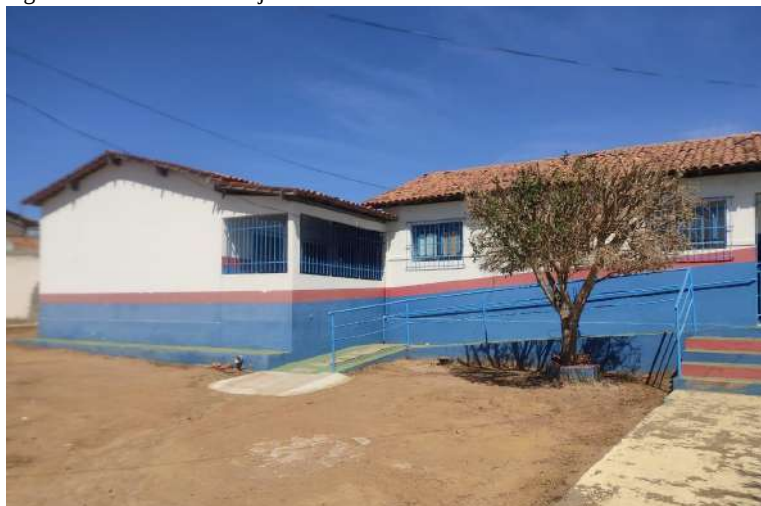
Figura 02 – foto da escola já existente
