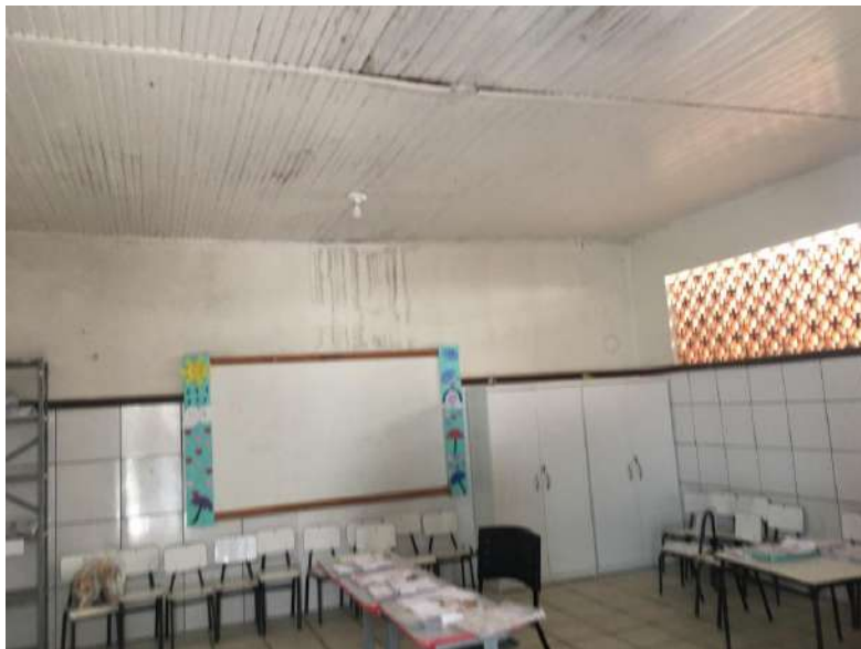
Figura 6: Sala foto interna.
