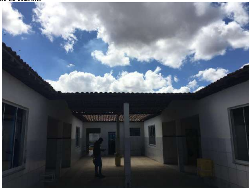
Figura 26: Telhado do pátio.
