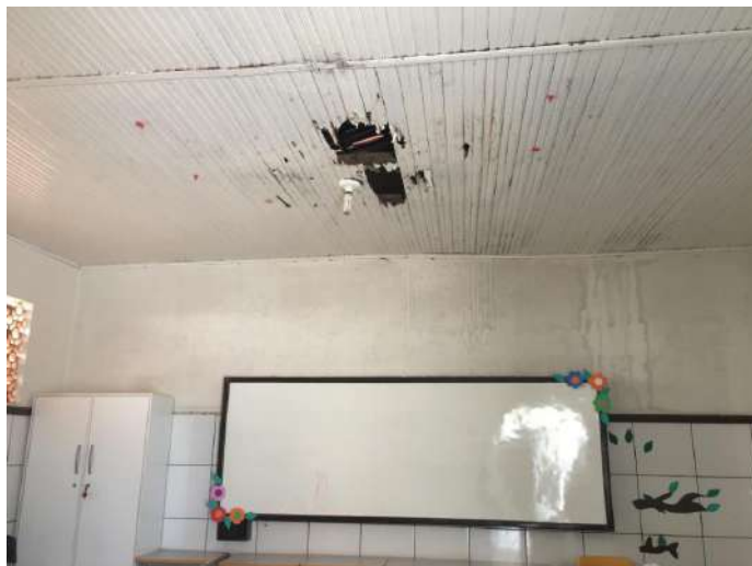
Figura 8: Forro de uma das salas.
