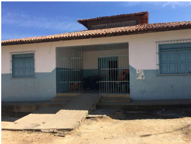
Figura 2: Fachada interna da escola.
