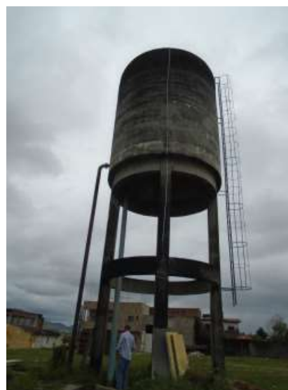
Foto 15 – Reservatório elevado de distribuição (100 m 3 )
