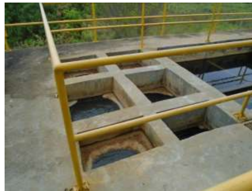
Foto 12 - Floculadores, decantadores e filtros - Foto 13 – Floculadores (ETA) (ETA)
