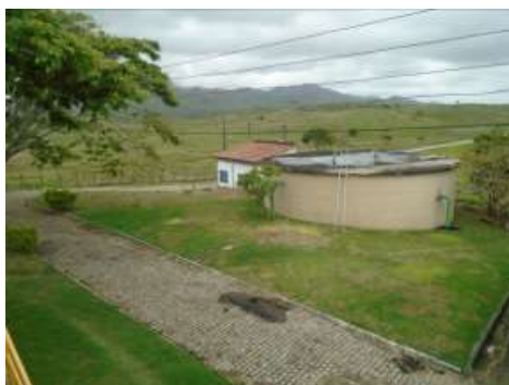
Foto 14 – Poço de sucção da estação elevatória de água tratada (EEAT, 400 m 3 ) - ETA
