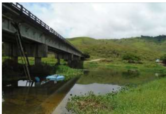
Foto 08 – Captação rio Pardo
