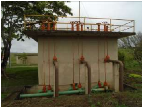
Foto 12 - Floculadores, decantadores e filtros - Foto 13 – Floculadores (ETA) (ETA)
