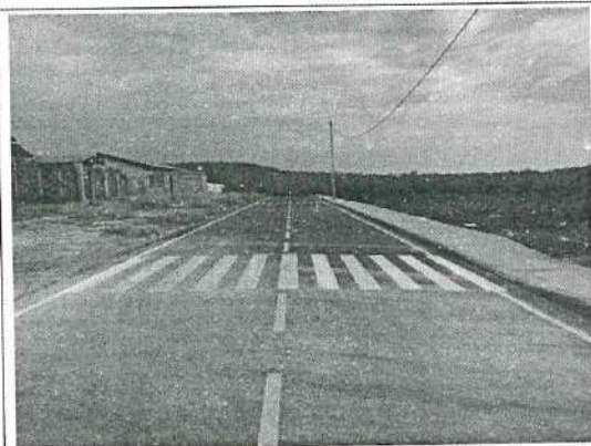
Foto 09 - Avenida Projetada - Trecho 1 (Próximo à estaca 00)
