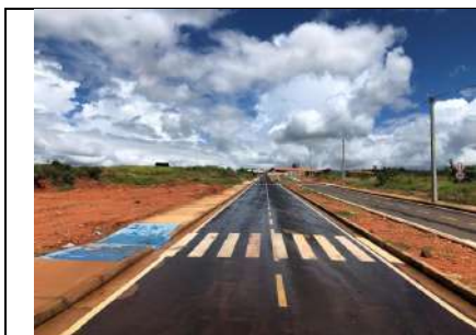
FOTO 21 – Estaca 0 sentido estaca 8. Serviço de pavimentação asfáltica, passeio, rampas, sarjeta, meio fio, sinalização vertical e horizontal.
