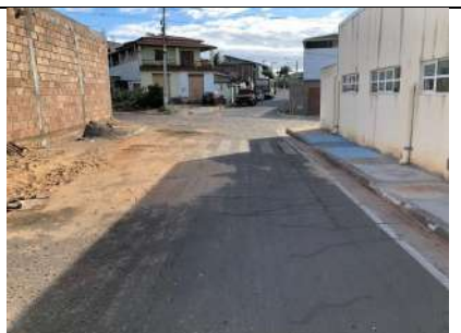
FOTO 20 – Estaca 03 sentido estaca 03+4,02. Observação para correções de fissuras e surgimento de novas fissuras.
