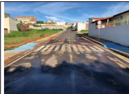
FOTO 1 – Estaca 01, sentido estaca 06. Observação para afundamento da via nos pontos apresentados.
