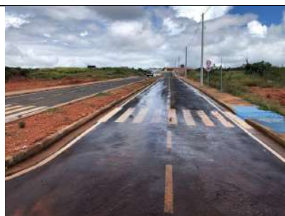
FOTO 22 – Estaca 0 sentido estaca 8. Serviço de pavimentação asfáltica, passeio, rampas, sarjeta, meio fio, sinalização vertical e horizontal.
