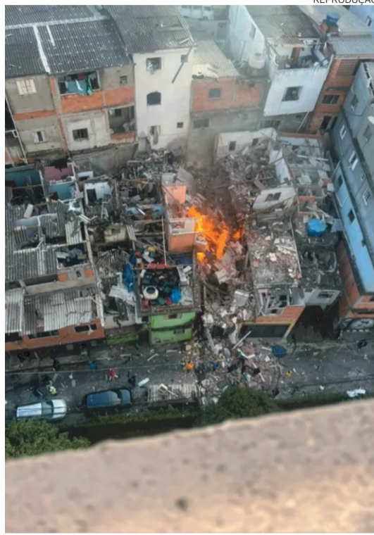
Incidente foi provocado por obra da Sabesp
