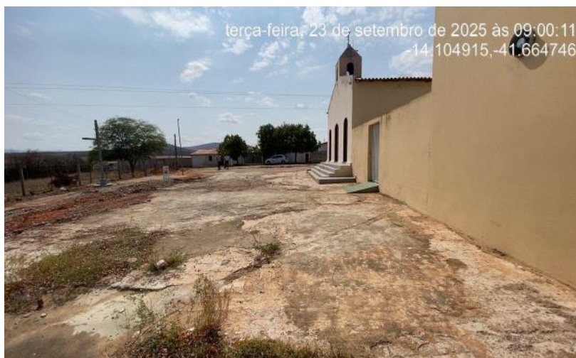
Foto 02: Local da Obra.
