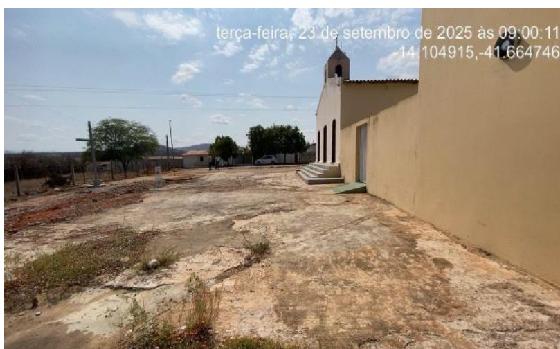
Foto 04: Local da Obra.
