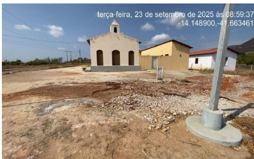
Foto 01: Local da Obra.
