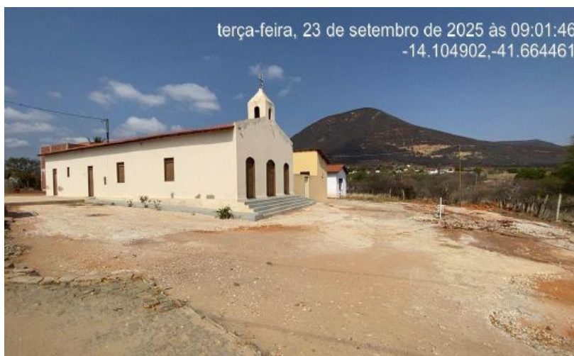
Foto 03: Local da Obra.
