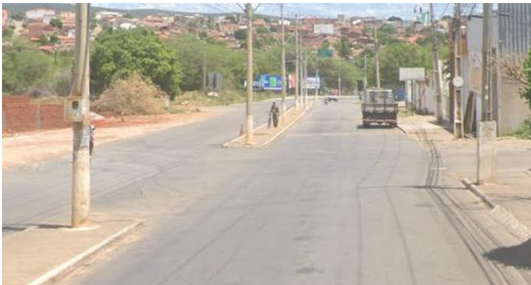
Imagem 1 - Visão geral do trecho anterior ao local de fiscalização
