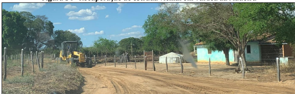
Figura 54 - Recuperação de estrada vicinal em Várzea da Madeira
