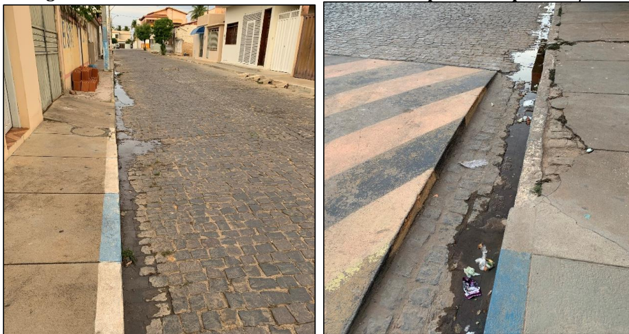
Figura 50 - Caimento lateral das vias da sede municipal de Tanque Novo/BA
