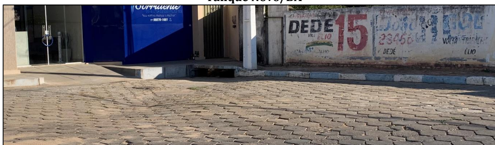
Figura 51 - Boca de lobo no final da Rua Jovino Alves de Oliveira, na sede municipal de Tanque Novo/BA
