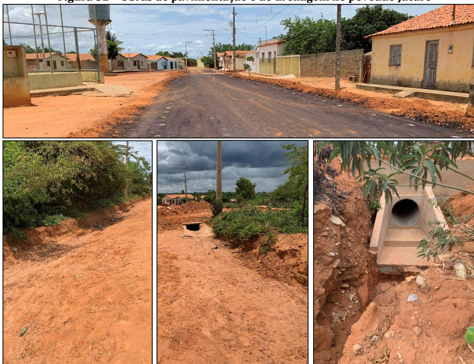
Figura 52 – Obras de pavimentação e de drenagem no povoado Jacaré
